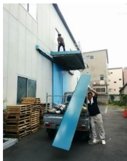
工場の屋根押えの修理
