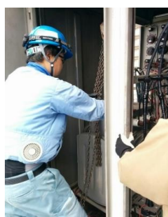
変電設備修理
