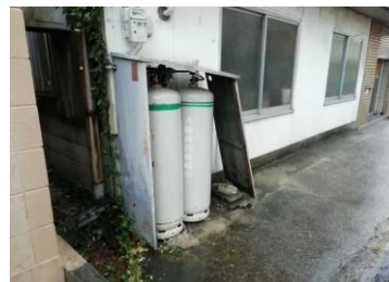
LPG置き場のカバーが突風で飛ばされた
