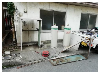
LPG置き場の新カバー設置工事
